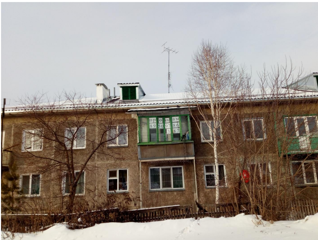
с.Сухобузимское ул.Сельская д.8 ремонт крыши
